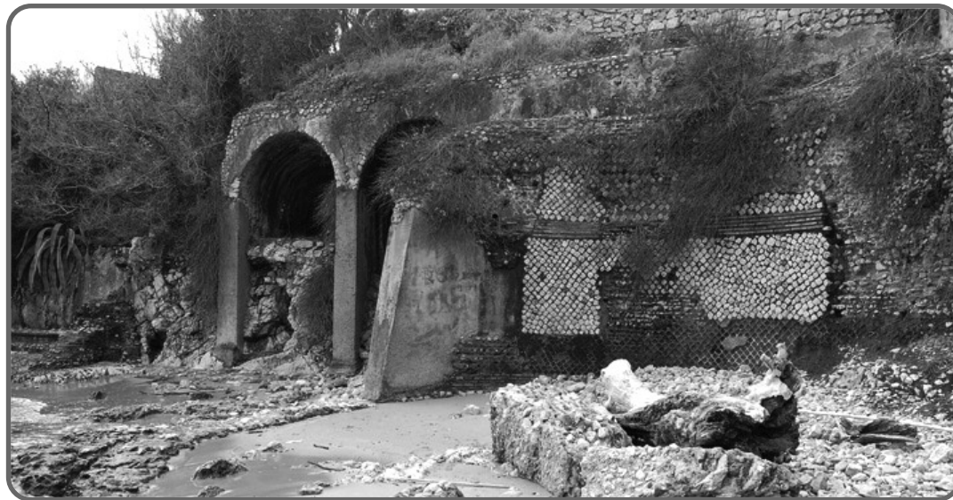
I RESTI DELLA VILLA DI FONTANIA E LO STATO DI DEGRADO NEL QUALE VERSA
